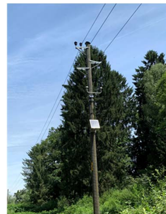
Slika 4 – ALiSa sa solarnim napajanjem na DV 10 kV-Ljubljana Barje
